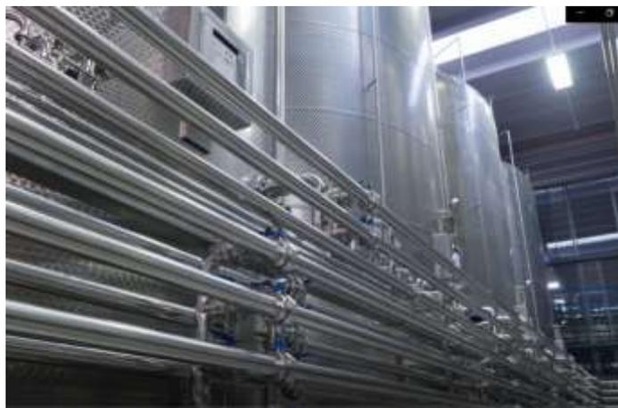
Installazione di n° 9 autoclavi orizzontali da 102.400 L e n° 18 autoclavi verticali da 63.100 L; tutte in acciaio coibentate con tubazioni fisse di collegamento.
